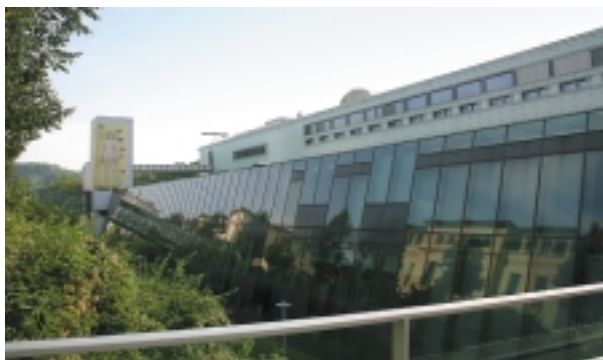
Ryc. 1. Lekko nachylona płaszczyzna elewacji wschodniej Fig. 1. Slightly inclined plane of the east elevation
