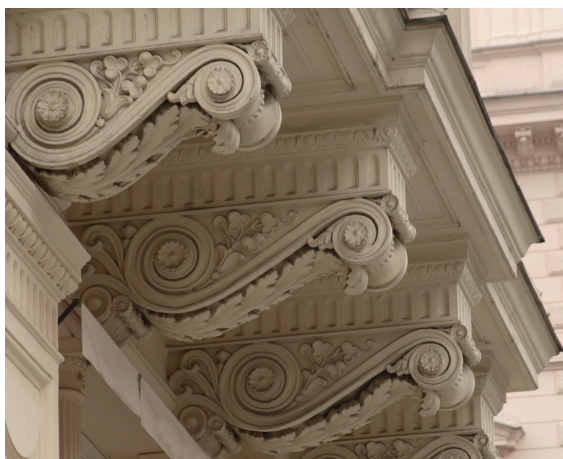
Rys. 1. Dekoracja architektoniczna jednej z wiedeńskich kamienic, wykonana z cementu romańskiego Fig. 1. Architectural decoration made from Roman cement on one of the apartment houses in Vienna
