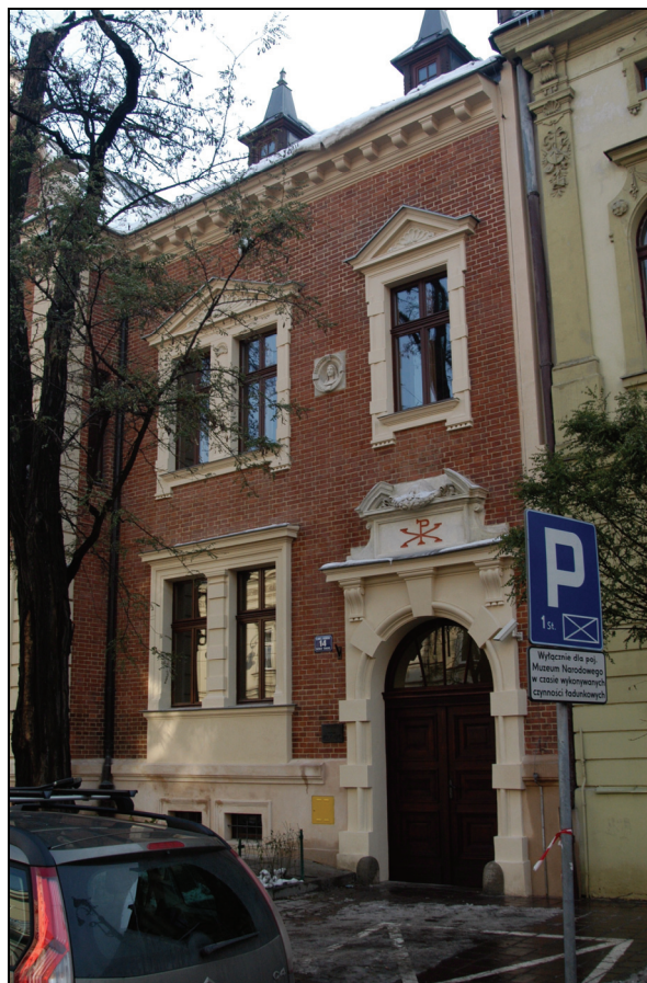
Rys. 9. Kamienica Łozińskich w Krakowie – stan po konserwacji Fig. 9. Łoziński House in Cracow after the conservation
