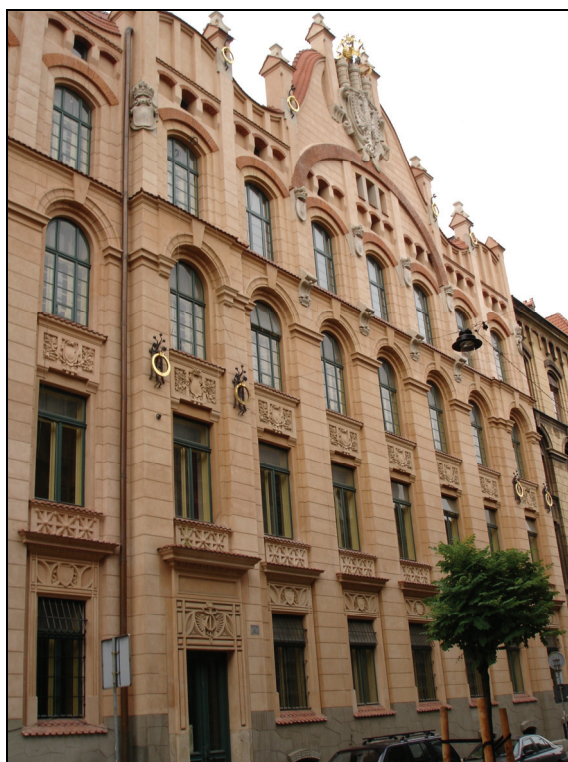
Rys. 7. Gmach dawnej Akademii Handlowej, pierwszego obiektu w Krakowie odnowionego za pomocą współcześnie wyprodukowanego cementu romańskiego
