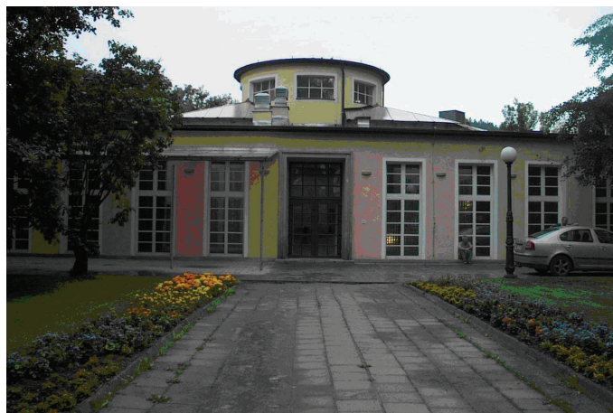
Rys. 1. Widok ogólny przedwojennego budynku pływalni Fig. 1. General view of post-german swimming pool building
