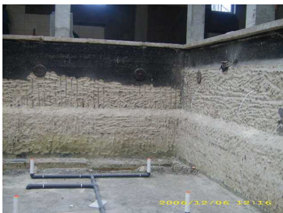
Rys. 4. Widok ścian niecki basenu po usunięciu płytek [1] Fig. 4. View of pool basin walls without ceramic tiles [1]
