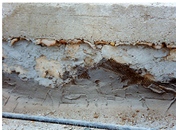
Preparation of vault's surface Przygotowanie powierzchni sklepienia
