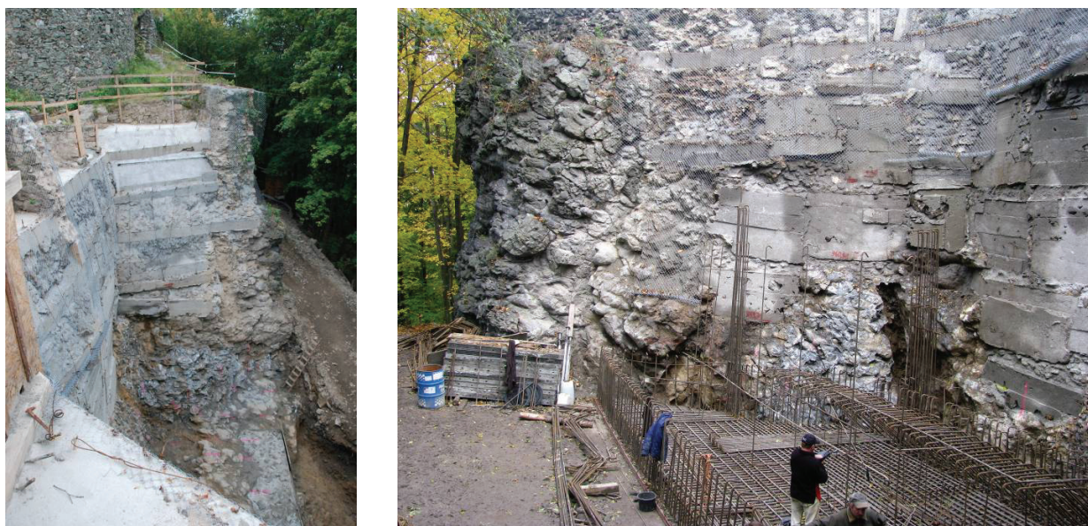
Rys. 7. Wzmocnienie skarpy oraz pierwsza faza wykonania zbrojenia odtwarzanego fragmentu murów obwodowych zamku (konstrukcja żelbetowa) Fig. 7. Slope strengthening and first stage of making of reinforcement for the reconstructed part of outer castle walls. (reinforced concrete)
