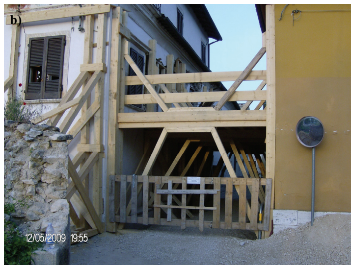
Fig. 7. Spur system (a) and Contrast system (b) Rys. 7. System przyporowy (a) i system kontrastowy (b)
