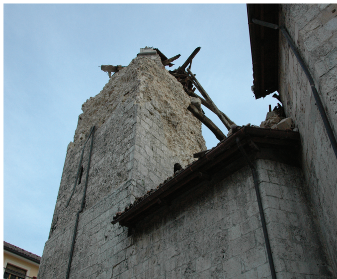
Fig. 5. The mechanism of “de-foliation” on the top of the tower trunk caused the rigid sliding of the Bell-Cell on the soil Rys. 5. Mechanizm “defoliacji” u góry trzonu wieży spowodował sztywne osunięcie się celi dzwonowej na ziemię
