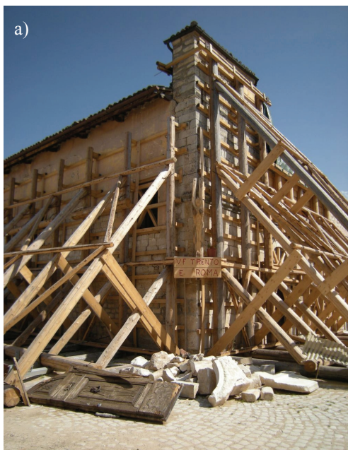
Fig. 7. Spur system (a) and Contrast system (b) Rys. 7. System przyporowy (a) i system kontrastowy (b)
