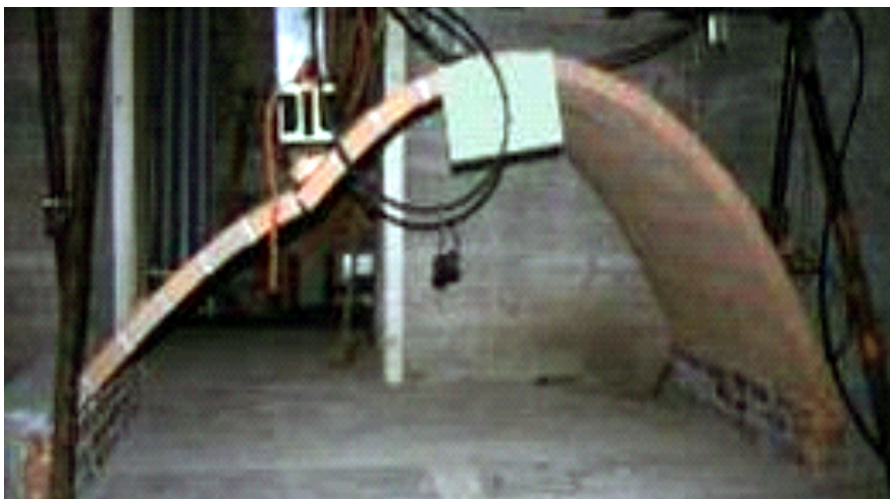
Fig. 19. Collapse mechanism of a vault strengthened using CFRP strips; [10] Rys. 19. Mechanizm zawalenia się sklepienia wzmocnionego przy użyciu taśm CFRP; [10]
