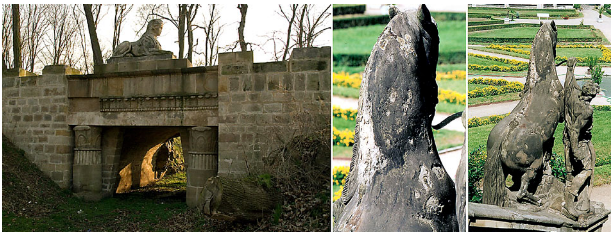
Fig. 6. Restored bridge before flood (left), damaged sandstone sculptures (right) with apparent corrosion defects Ryc. 6. Odnowiony most przed powodzią (po lewej), uszkodzone rzeźby z piaskowca (po prawej) z widocznymi uszkodzeniami korozyjnymi
