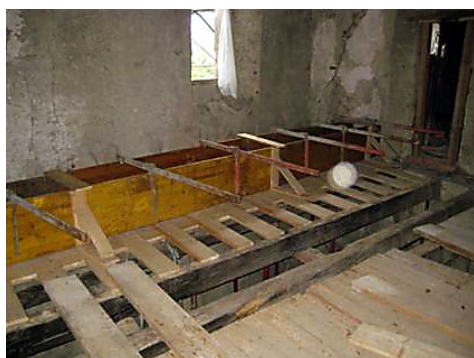
Fig. 5. On site bending test: loading system Rys. 5. Test zginania na miejscu: system obciążania
