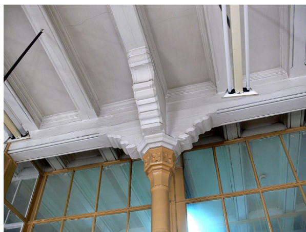
Rys. 8. Strop z powalą o profilowanych belkach drewnianych i profilowanych drewnianych podciągach Fig. 8. The ceiling with wooden beams of profiled cross-sections and wooden binding joists of profiled cross-sections
