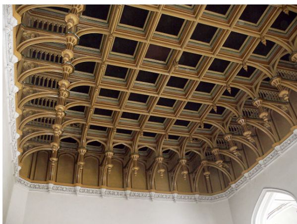
Rys. 7. Strop kasetonowy nad salą reprezentacyjną na I piętrze Fig. 7. The coffered ceiling over the stately hall on the 1 st floor
