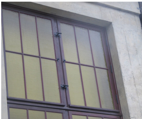
Rys. 6. Widok przykładowego okna Hali Stulecia po renowacji Fig. 6. The view of an example window of the Centennial Hall after renovation
