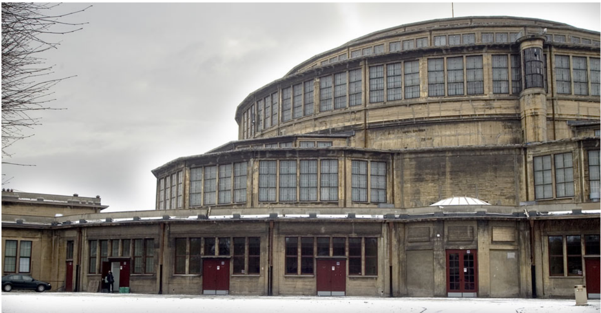
Rys.1. Widok ściany Hali Stulecia we Wrocławiu przed renowacją elewacji Fig. 1. The view of the wall of the Centennial Hall in Wrocław before the elevation renovation
