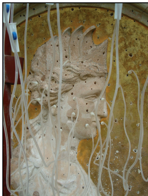
Rys. 2. Prace konserwatorskie przy rzeźbach na elewacjach pałacu
