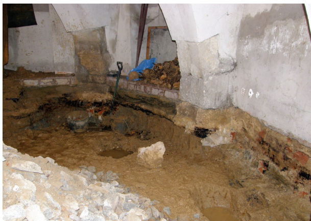
Rys. 13. Prace przy pogłębianiu krypty. W środku zdjęcia, u podstawy żebra widoczne szczątki szkieletów, które zostały pochowane pod posadzką krypty. Widoczna również woda gruntowa, zbierająca się w wykopach. Fot. A.J. Gaczoł, 2009
