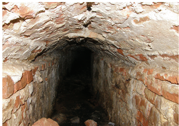
Rys. 14. „Zagadkowy” kanał wiodący pod prezbiterium kościoła odkryty w 2009 r. Fot. A.J. Gaczoł
