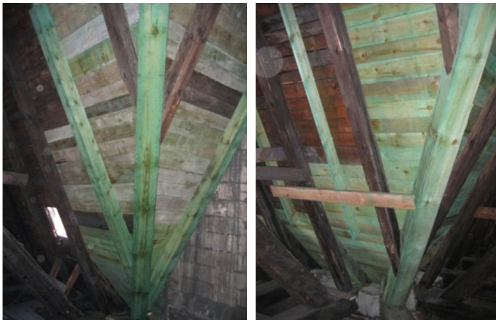
Rys. 2. Wymienione krokwie koszowe Fig. 2. Replaced valley rafters
