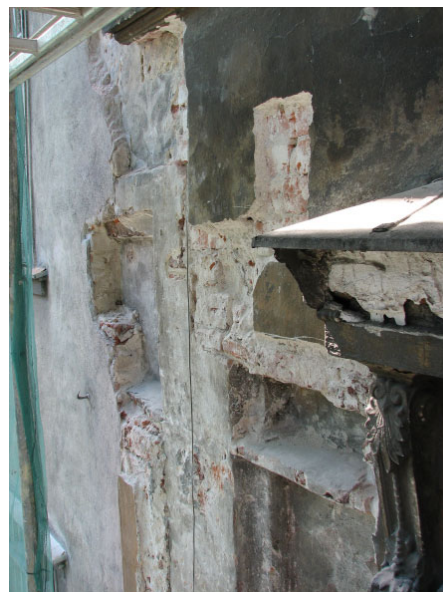
Rys 10. Brzeg, Dzierżonia 10, fragmenty blendy i dekoracyjnego fryzu. Foto A. Peszko Fig. 10. Brzeg, 10 Dzierżonia St., fragments of blind windows and a decorative frieze. Photo: A. Peszko
