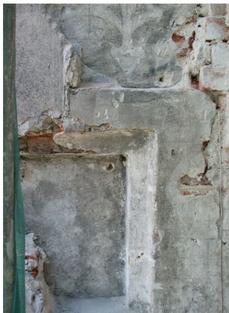
Rys. 11. Brzeg, ul. Dzierżonia 10, podziały naśladowujące wątek lica z ciosów kamiennych z wyraźnym zaznaczeniem spoin. Foto A. Peszko Fig. 11. Brzeg, 10 Dzierżonia St., divisions imitating the bond in stone-block face-work, with clearly marked joints. Photo: A. Peszko
