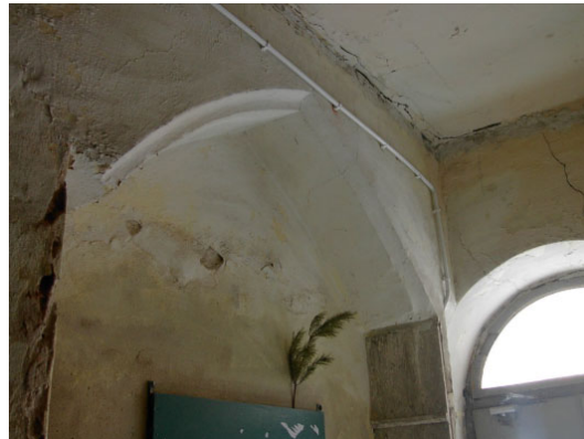
Rys. 3 Brzeg, ul. Reja 7, ostrołuczna, arkadowa wnęka na parterze kamienicy. Foto A. Peszko Fig. 3. Brzeg, 3 Rej St., ogival arcaded recess in the tenement house ground floor. Photo A. Peszko
