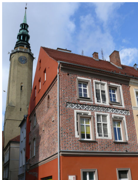
Rys 7. Brzeg, Sukiennice 5, elewacje wschodnia i południowa po zakończeniu prac konserwatorskich. Foto A. Peszko Fig. 7. Brzeg, 5 Sukiennice, eastern and southern elevations after conservation work. Photo: A. Peszko
