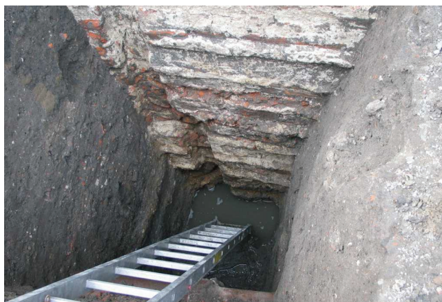
Rys. 13. Odkrywka fundamentu ściany Fig. 13. View of wall foundation pit
