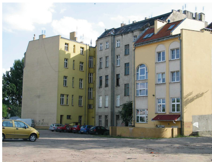
Rys. 5. Widok zespołu budynków od strony projektowanego wykopu Fig. 5. View of group of buildings from excavation site
