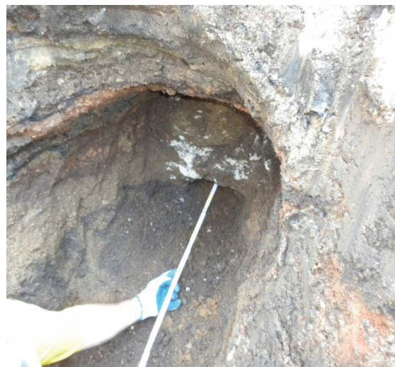
Rys. 4. Widok odkrywki fundamentu ściany Fig. 4. View of foundation pit
