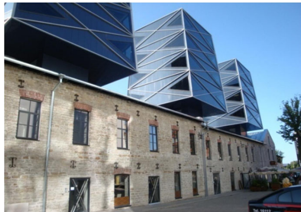
Rys. 5. Stary skład mąki w Tallinnie po rewitalizacji Fig. 5. Old flour store in Tallinn after revitalization
