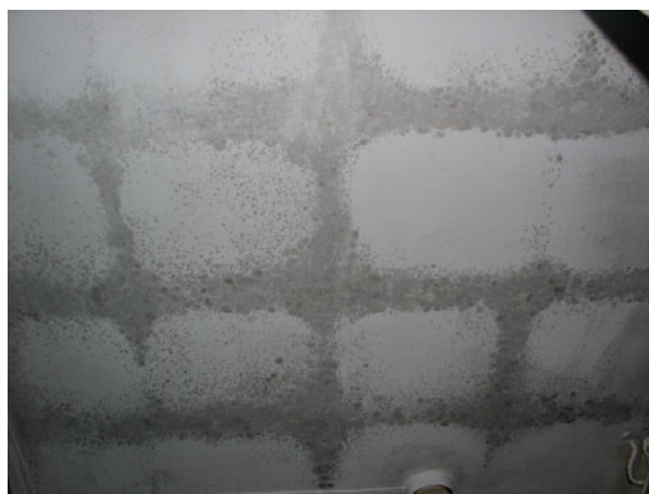
Rys. 8. Skrzydło południowe. Widok „przemarzających” żeber stropu. Główną przyczyną występowania tego zjawiska jest zbyt mała izolacyjność termiczna stropodachu Fig. 8. Southern wing. View of freezing slab-rib ceiling. The main reason for its occurrence is unsatisfactory thermal insulation of the flat roof
