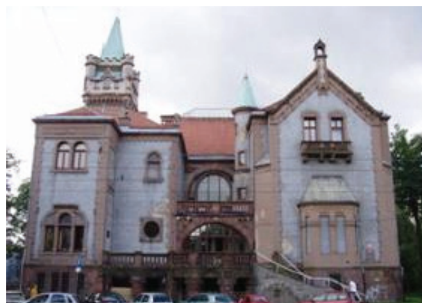
Rys. 3. Widok elewacji północnej Fig. 3. North facade
