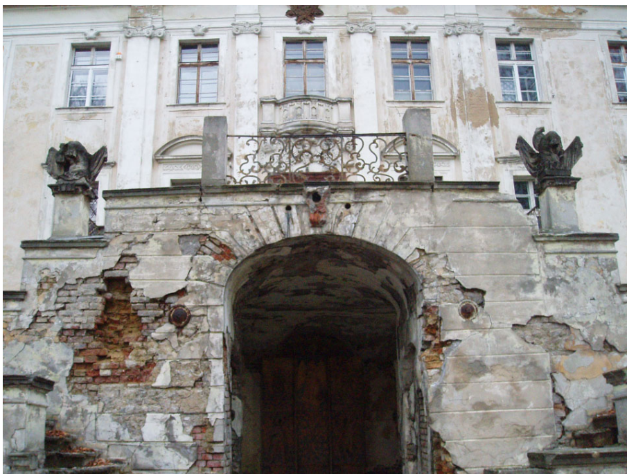
Rys. 2. Taras od strony południowej – widok przed remontem Fig. 2. South terrace – view before renovation
