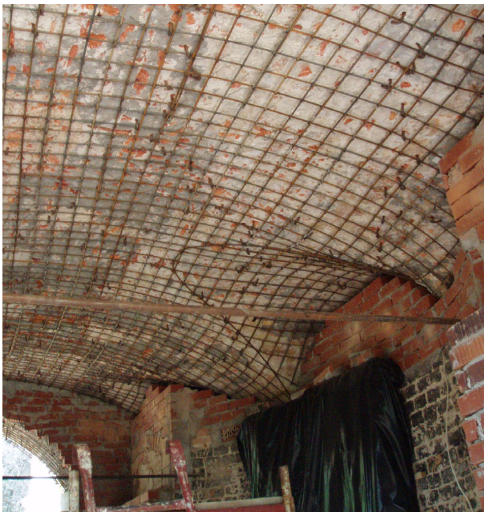
Rys. 10. Taras południowy – widok naprawy sklepienia Fig. 10. South terrace – view of the terrace vault being repaired
