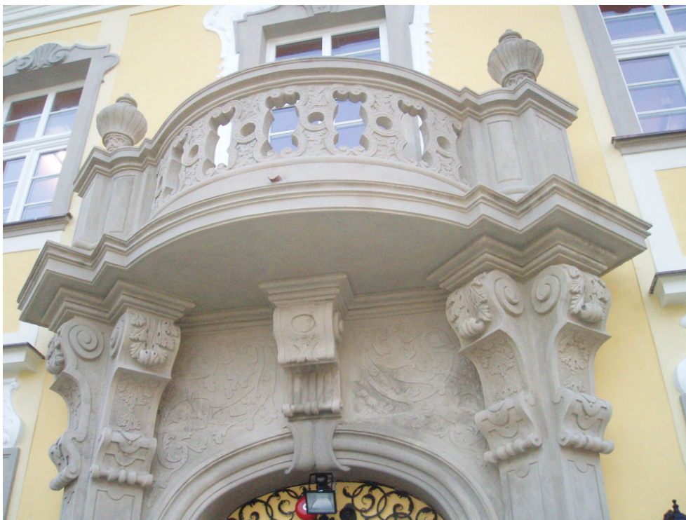
Rys. 11. Balkon i portal nad wejściem głównym – efekt końcowy Fig. 11. The balcony and the portal above the main entrance – final view after renovation
