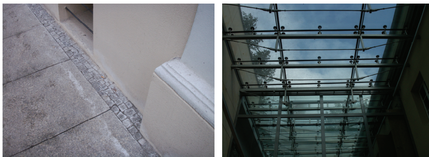
Rys. 6. a) posypywanie ulic solą, b) stalowe dźwigary pod przeszkleciem Fig. 6. a) sprinkling salt on streets, b) steel girders under the glass ceiling
