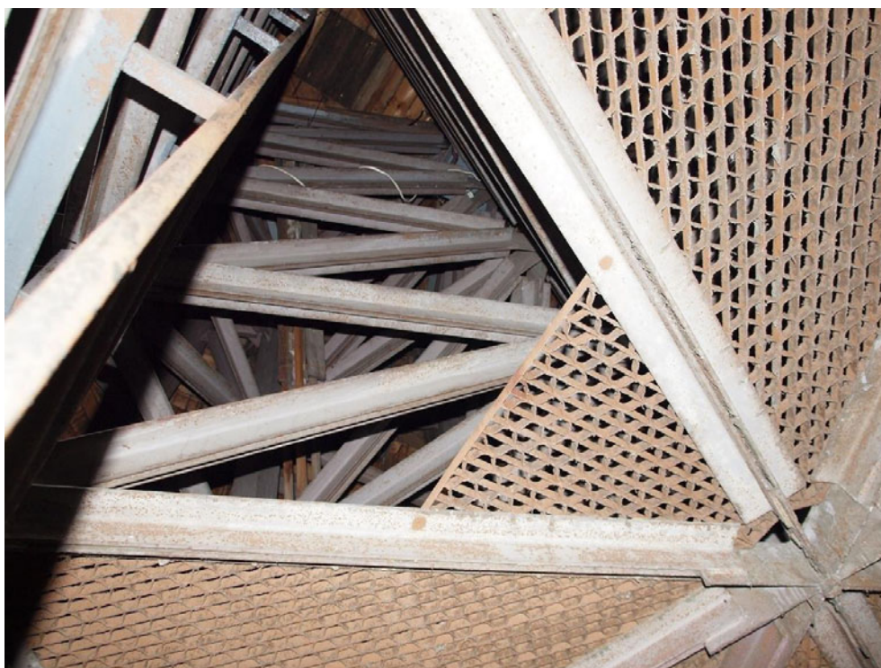
Rys. 8. Słup sercowy hełmu Fig. 8. Central pillar
