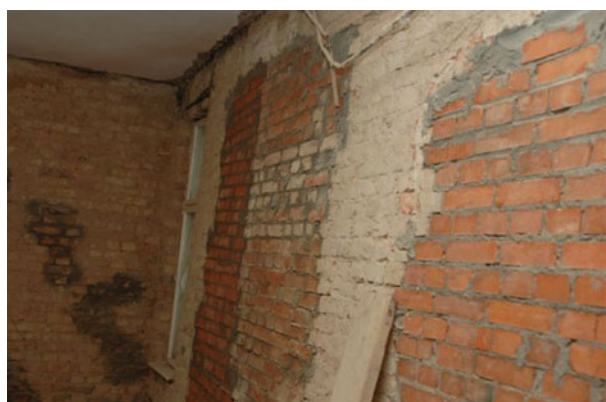
Rys.12. Przemurowania ściany Fig. 12. Repair of masonry
