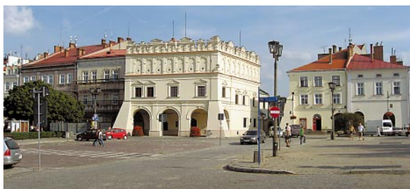
Ryc. 5. Widok pierzei rynku z kamienicą Orsetti na pierwszym planie Fig. 5. View of the Market Square frontage with the Orsetti tenement house in the foreground
