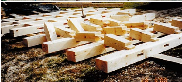
Ryc. 10. Chojna (pow. wągrowiecki w Wielkopolsce) Kościół szkieletowy z 1776 r. „uległ” tzw. konserwacji. Niewielkie uszkodzenia dolnych partii stały się powodem rozebrania świątyni i postawienia „kopii” z nowego odżywiczonego drewna, które dość szybko ulegnie zniszczeniu. Do takiej dewastacji nieodpowiedzialny projektant przekonał inwestora, który potem żałował tej decyzji. Fig. 10. Chojna (Wągrowiec district in Greater Poland) The skeleton church from 1776 underwent the so-called conservation. Little damage of its lower parts was the reason for demolishing the church and erecting a “copy” made from new timber, deprived of resin, which will quickly deteriorate. An irresponsible designer persuaded the investor, who later regretted his decision, to approve of this devastation.
