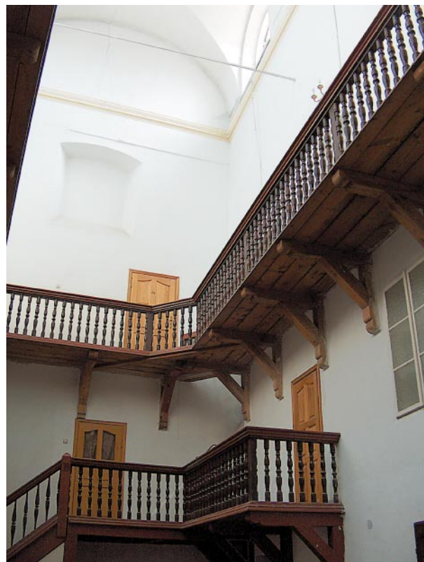
Ryc. 1. Wiata kamienicy jarosławskiej – Kamienica Radzikowska Fig. 1. Inner courtyard of a tenement house in Jarosław – Radzikowski house
