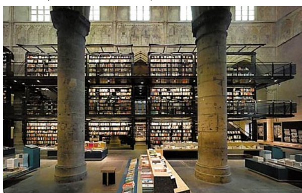
Ryc. 9. Widok na wnętrze kościoła Dominikanów po adaptacji świątyni na księgarnię – trzykondygnacyjna struktura na książki, (źródło: Dezeen. Architecture and design magazine, 12. 2007, fot. Roos Aldershoff) Fig. 9. View of the Dominican church interior after converting it into a bookshop – three-storey structure where books are kept, (source: Dezeen. Architecture and design magazine, 12. 2007, fot. Roos Aldershoff)
