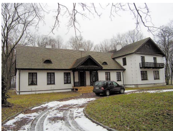
Ryc. 3. Elewacja frontowa drewnianego dworu w Leścach Fig. 3. The front elevation of the wooden manor house in Leśce
