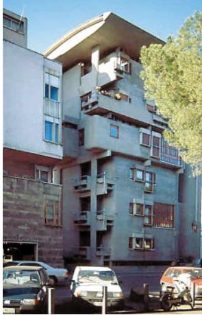
Ryc. 7. Budynek mieszkalny Florencja via Piagentina, L. Saviolli 1971 Fig. 7. A residential building, Florence via Piagentina, L. Saviolli 1971
