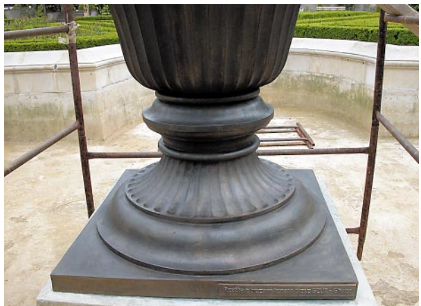
Ryc. 3. Chłopiec z łabędziem, brąz, partia dolna po powtórnym patynowaniu i zabezpieczeniu antykorozyjnym Fig. 3. The Boy with the Swan, bronze, state after the second patinating and applying an anti-corrosive layer
