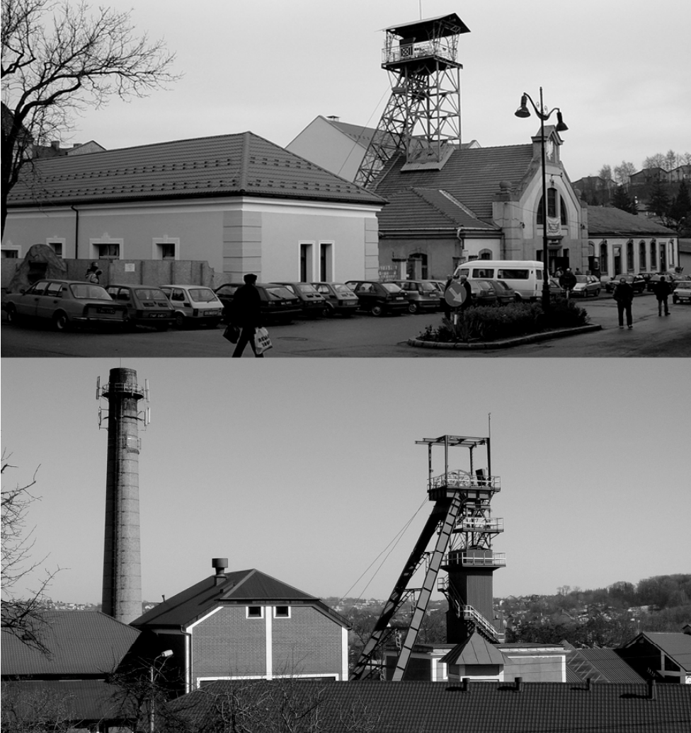
II. 1. Nadszybie „Sutoris” (u góry) oraz zespół szybowy „Campi” – przestrzenie publiczne na styku miasta podziemnego i nadziemnego
