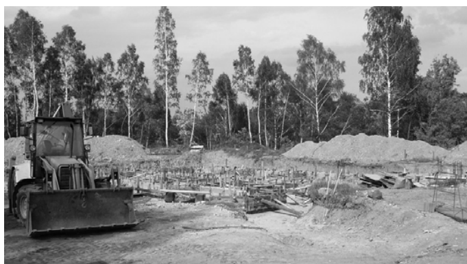
Rys. 4. Prace budowlane w rezerwacie Segiet w Lesie Hipolit w Bytomiu
