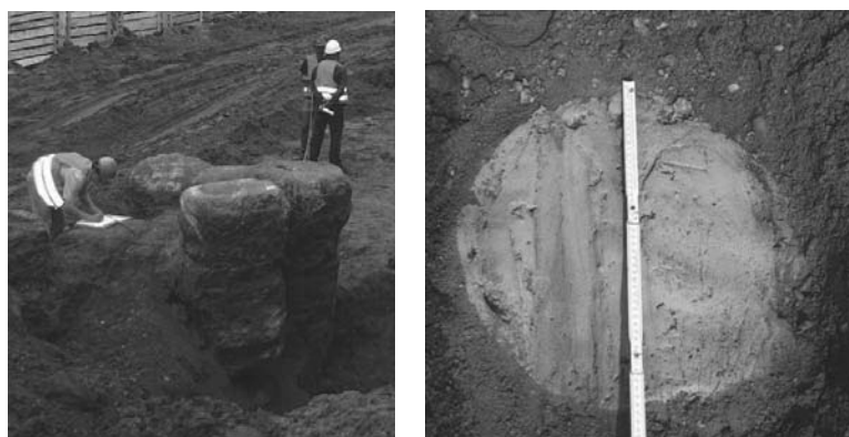
Fig. 3. Injection columns after excavation Rys. 3. Kolumny iniekcyjne po wykonaniu odkrywki
