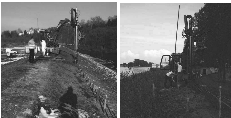
Fig. 1. Installation of injection pipes Rys. 1. Instalacja rur iniekcyjnych
