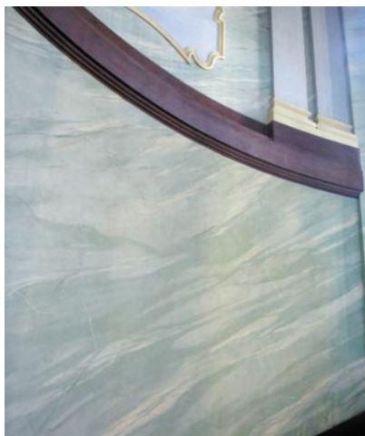
Ryc. 4. Wnętrze neobarokowej klatki schodowej – stan po konserwacji Fig. 4. Interior of the Neo-Baroque staircase – after conservation
