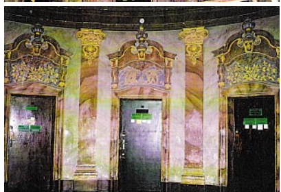
Ryc. 3. Neobarokowe wnętrze klatki schodowej – stan przed konserwacją Fig. 3. Interior of the Neo-Baroque staircase – before conservation
