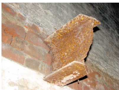
Ryc. 10. Stropowa belka stalowa
