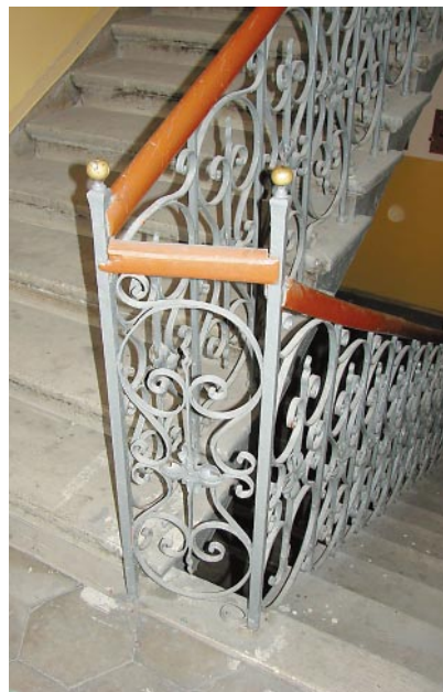
Ryc. 14. Fragment wnętrza klatki schodowej
