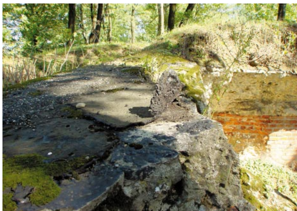
Ryc. 17. Izolacja bitumiczna pozioma – fort nr XIIIb w Boleszycach
