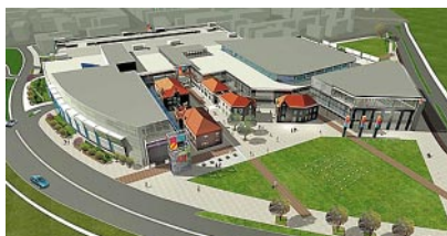
Galeria „Kazimierz” w miejscu dawnej Rzeźni Miejskiej. Fotografia ze strony internetowej www.penetron.pl . Zwracają uwagę zachowane budynki z 1910 r.
