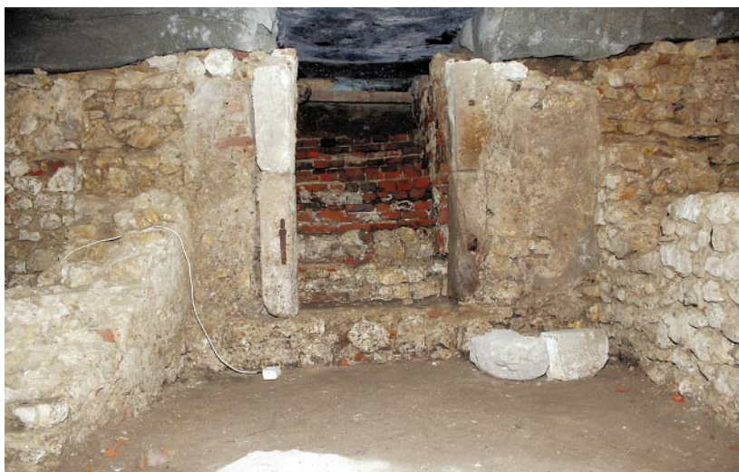
Pierwotny otwór wejściowy do piwnicy Kramów Bogatych
