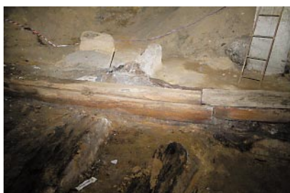
XIII-wieczny wodociąg wykonany z drążonych belek drewnianych
