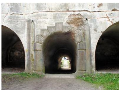
Ryc. 5. Przejście główne wraz z zachowanym nad nim napisem
