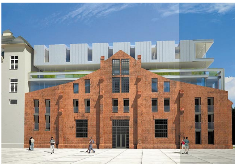
Elektrownia na Kazimierzu. Elewacja zachodnia hali kotłowni, z wyeksponowaniem fasady projektu Jana Rzymkowskiego. Reprodukacja przekazana przez B2 Studio
