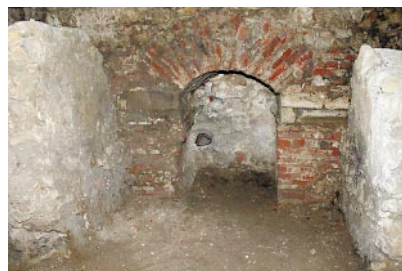
Kramy Bogate – widok na wzmocnione ceglanymi łękami fundamenty Sukiennic
