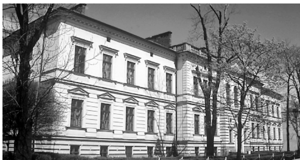
Ryc. 6. Klinika Chirurgiczna, ul. Kopernika 40, elewacja frontowa, 2006 r. (fot. aut.)
