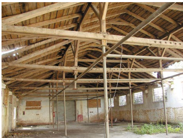
Ryc. 15. Fragment drewnianej konstrukcji dachowej w zespole pokoszarowym przy ulicy Herburtów
