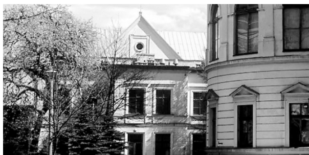
Ryc. 7. Klinika Chirurgiczna, ul. Kopernika 40, elewacja tylna, sala wykładowa, 2006 r. (fot. aut.)
