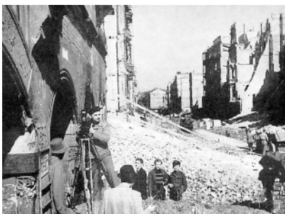
Ryc. 2. Powojenne zniszczenia centrum Wrocławia – rok 1945 (fot. arch.)
