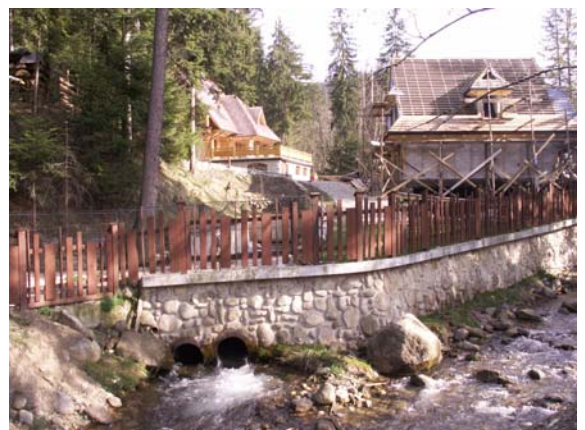
II. 6. Elektrownia wodna na Chłabówce III. 6. Hydroelectric power plant in Chłabówka
