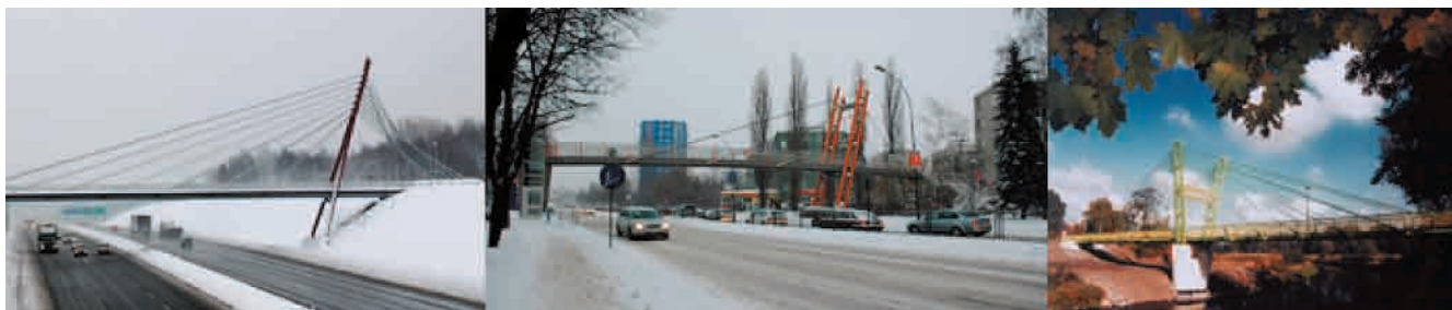
Il. 1. Kładki o konstrukcji podwieszanej, od lewej w: Rudzie Śląskiej, Kielcach i Wrocławiu (fot. aut.).
