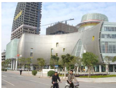
Ryc. 1. Przestrzenna elewacja z siatki stalowej Fig. 1. Three-dimensional steel net façade
