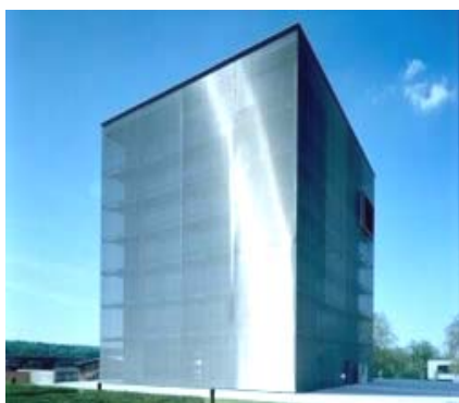
Ryc. 3. Refleksy słoneczne na siatce elewacji Fig. 3. Sunlight glare on steel net façade
