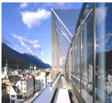
Ryc. 6. Osłony przeciwsłoneczne z siatki stalowej Fig. 6. Steel nets as sun screens
