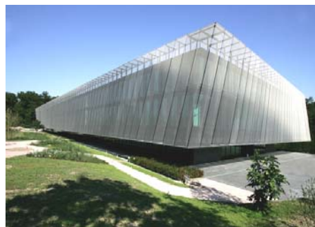
Ryc. 4. Maskowanie artykulacji przeszklenia przez siatkę stalową Fig. 4. Masking effect of façades by steel net second skin
