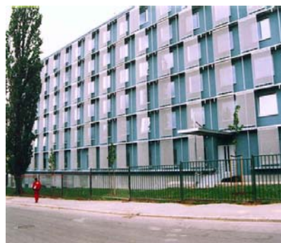
Ryc. 6. Osłony przeciwsłoneczne z siatki stalowej Fig. 6. Steel nets as sun screens
