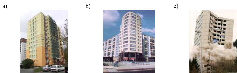
Ryc. 1. Przykłady modernizacji budynków wielkopłytowych: a) docieplenie ścian budynku 11-kondygnacyjnego, b) wypełnienie luki między dwoma budynkami w Berlinie [3], c) wyburzenie 16-kondygnacyjnego budynku wielkopłyтового w Paryżu
