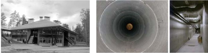
Ryc. 3. Szkoła w Nesodden. Gruntowy zasobnik powietrza Fig. 3. School in Nesodden. Underground container of air
