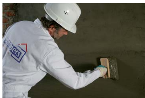
Ryc. 2. Drobnoziarniste zaprawy uszczelniające nakłada się na całą powierzchnię miękkim pędzlem
