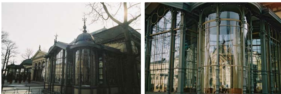
Ryc. 2. Adaptacja altany na kawiarnię w centrum Helsinek. Fot. Robert Marcinkowski, 2004
