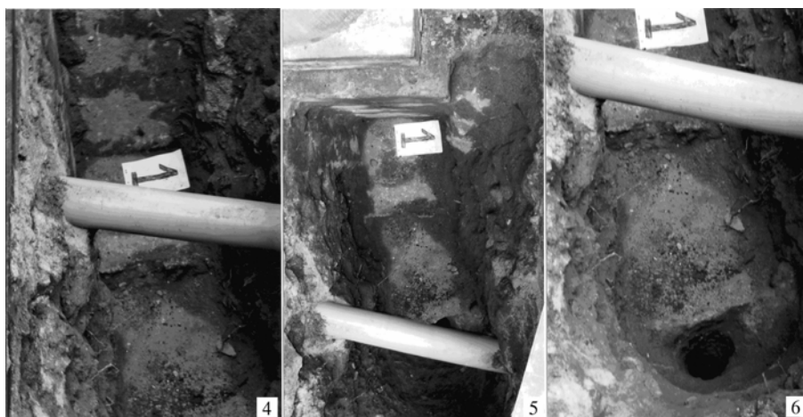
Ryc. 4, 5, 6. Widoki odwiertu geologicznego nr 1
