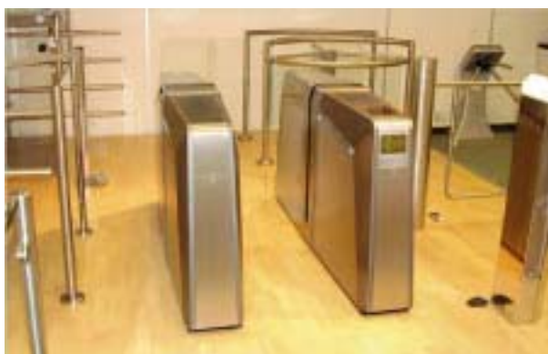
Ryc. 2. Bramka ITABmk Fast Trek umożliwiającą dokładną analizę statystyczną ruchu osobowego
