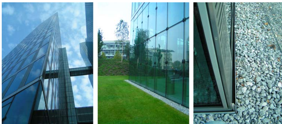
Ryc. 1. HighLight Bussines Towers, Monachium: fasada, jej styk z podłożem, detal liniowego odwodnienia obwodowego. Fot. Łukasz Wesołowski
