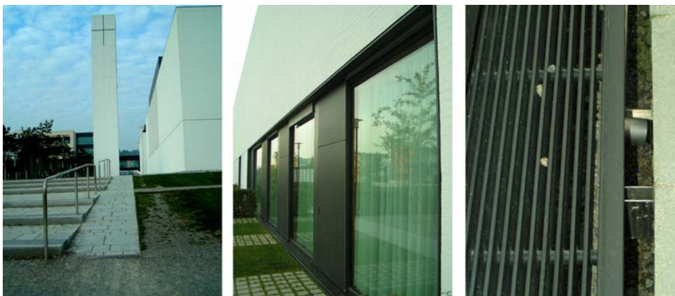
Ryc. 3. Katolickie Centrum św. Floriana, Monachium: bryła zewnętrzna, przeszkleń, detal odwodnienia liniowego przy elewacji. Fot. Łukasz Wesołowski
