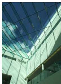
Ryc. 1. Widok na szklane belki i detal połączenia ze sobą szklanych elementów (www.arup.com)
