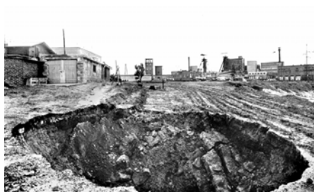
Ryc. 1. Zapadlisko terenu nad Kopalnią Soli „Wapno” – stan po katastrofie z 1977 r. (fot. aut., 2007)
