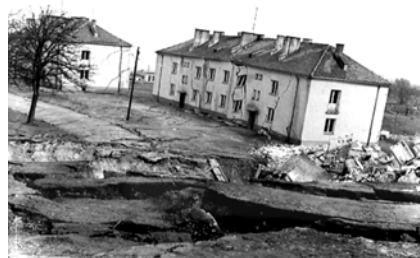
Ryc. 2. Szkody górnicze po katastrofie w Kopalni Soli „Wapno” (źródło: Urząd Gminy w Wapnie)
