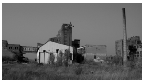
Ryc. 5. Zachowany zespół obiektów Kopalni Soli w Wapnie (fot. aut., 2007)
