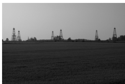
Ryc. 3. Wieże otworowe Kopalni Soli „Mogilno” (fot. aut., 2007)
