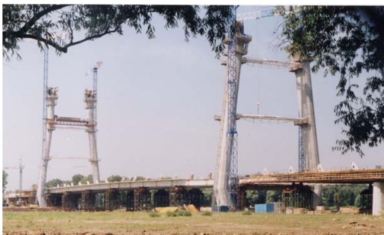
Ryc. 2. Tymczasowe rozpory podczas budowy pylonu Mostu Siekierkowskiego Fig. 2. Temporary struts during building of pylon of the Siekierkowski Bridge
