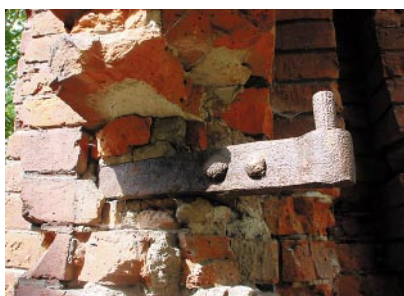
Ryc. 4. Zawias w bramie wejściowej
