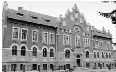
Ryc.5. Budynek sądu rejonowego – elewacja frontowa odnowiona w 2007 roku – zdjęcie autora
