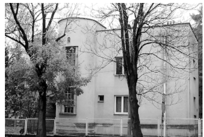
Ryc.12. Modernistyczna willa przy ul. Wypiańskiego – zdjęcie autora
