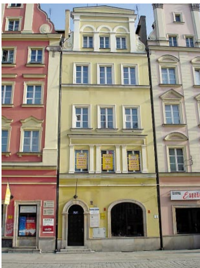
Ryc. 13. Rażąca biała kolorystyka ram okiennych oraz nieuzasadniona redukcja detali architektonicznego wystroju kamienicy nr 56/57 przy wrocławskim Rynku w pierzei pñ. (fot. autor)
