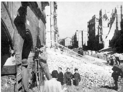
Ryc. 2. Powojenne zniszczenia centrum Wrocławia – rok 1945 (fot. arch.)
