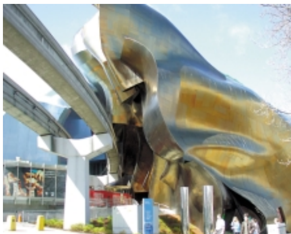
Fot. 6. EMP w Seattle, fragment elewacji. Autor: Błażej Kotelko
