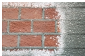
Metoda piaskowania i mikropiaskowania. Użycie agregatów pracujących metodą strumieniową, gdzie odpowiednio dobranym ścierniwem pod regulowanym ciśnieniem usuwa się warstwę z lica cegły
