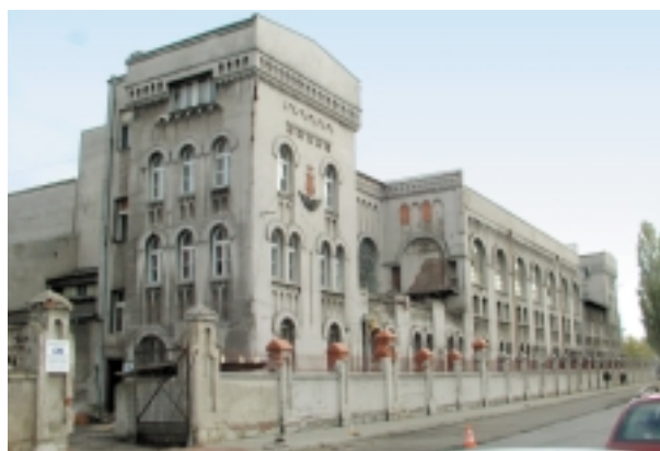
Budynek dawnej Elektrowni Tramwajowej w Warszawie – 1905. Elewacje budynku pokryte w latach 70. warstwą obrzutki cementowej
