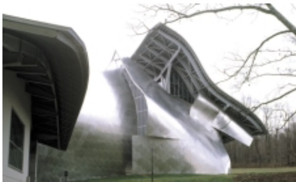
Fot. 10. Bard College, fragment elewacji. Autor: Dorota Czerner
