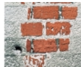
Metoda ręcznego odkuwania warstw cementowej obrzutki z użyciem dłut
