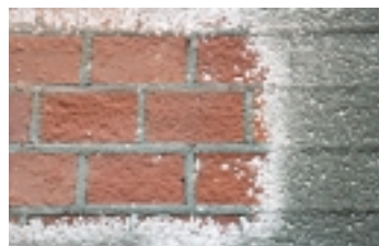
Metoda piaskowania i mikropiaskowania. Użycie agregatów pracujących metodą strumieniową, gdzie odpowiednio dobranym ścierniwem pod regulowanym ciśnieniem usuwa się warstwę z lica cegły
