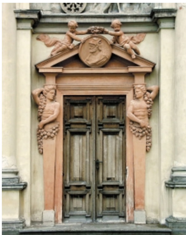
Galeria południowa – elewacja zachodnia po konserwacji. Fot. W. Markiewicz
