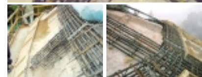
Rys. 21. Zbrojenie drugiego, trzeciego i czwartego żebra równoleżnikowego wraz ze zbrojeniem żeber południowych
