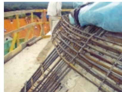
Rys. 20. Zbrojenie pierścienia dolnego, rozciąganego
