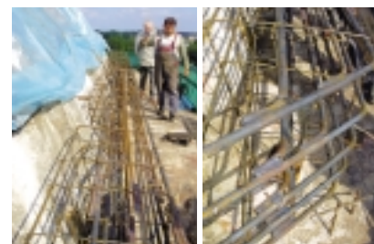
Rys. 20. Zbrojenie pierścienia dolnego, rozciąganego
