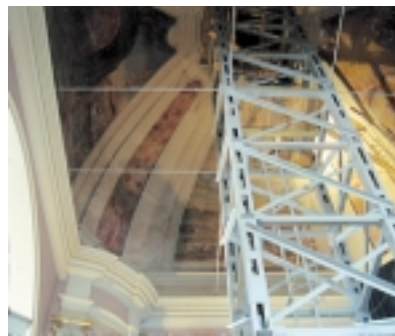
Rys. 15. Kopuła w Owińskach – widok tymczasowego podparcia latarni kopuły
