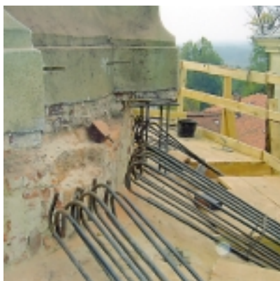
Rys. 23. Przygotowane do zakotwienia w pierścieniu górnym, ściskanym, zbrojenie żebra południkowego
