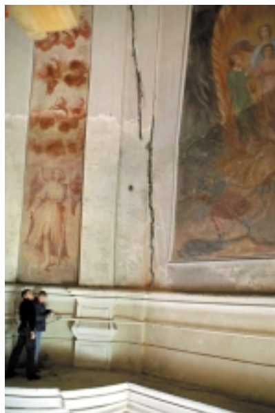
Rys. 30. Rysa o przebiegu południkowym po iniekcji kompozycją epoksydową
