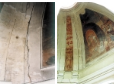
Rys. 5. Jedna z rys o przebiegu południkowym i spękanie naroża pn.-zach. [1], [2], [3]
